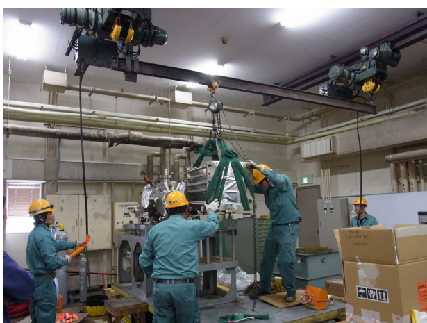
図 1 7 スピンフィルター移設作業
