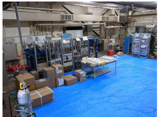
図 2 4 移設完了後の9階旧イオン源室
