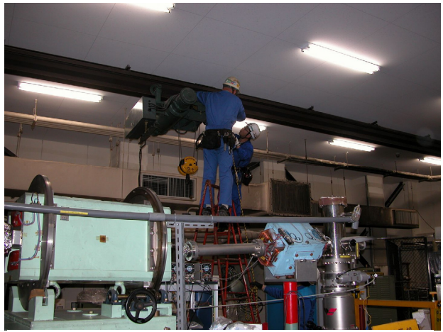
図2 天井クレーン脱輪緊急修理
