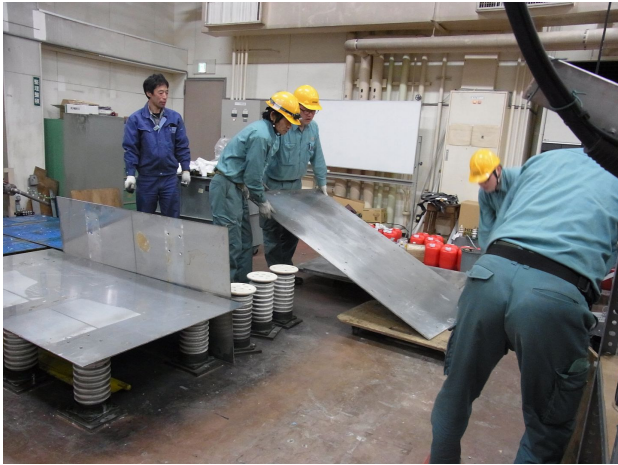
図 1 9 高電圧架台分解、廃棄
