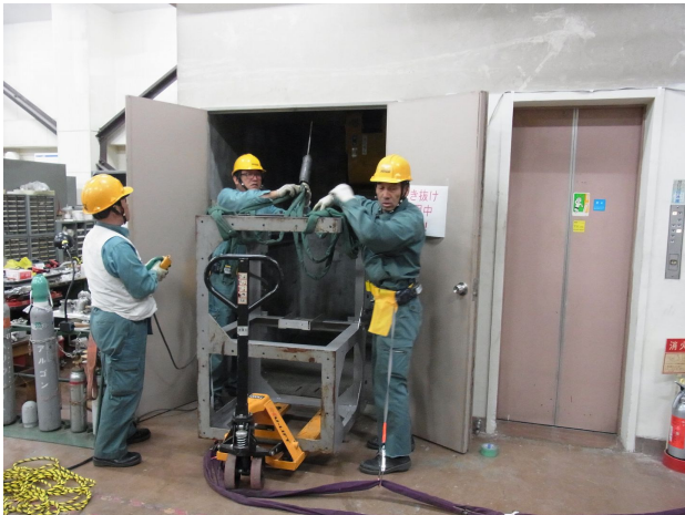
図 2 1 チャンバー架台吹き抜けて1階へ
