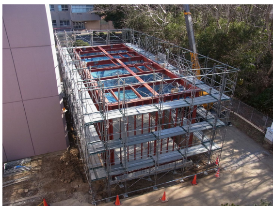
図 9 鉄骨組み
