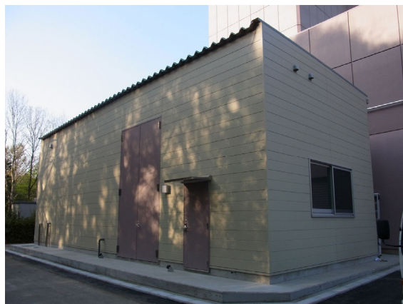
図 12 完成した偏極イオン源棟外観
