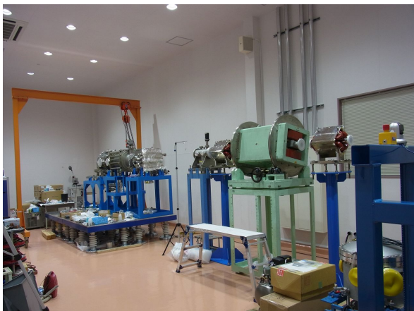
図15 全コンポーネントの仮設置完了
