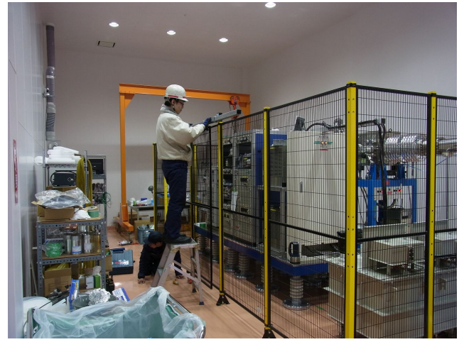
図18 高電圧防御フェンスの設置
